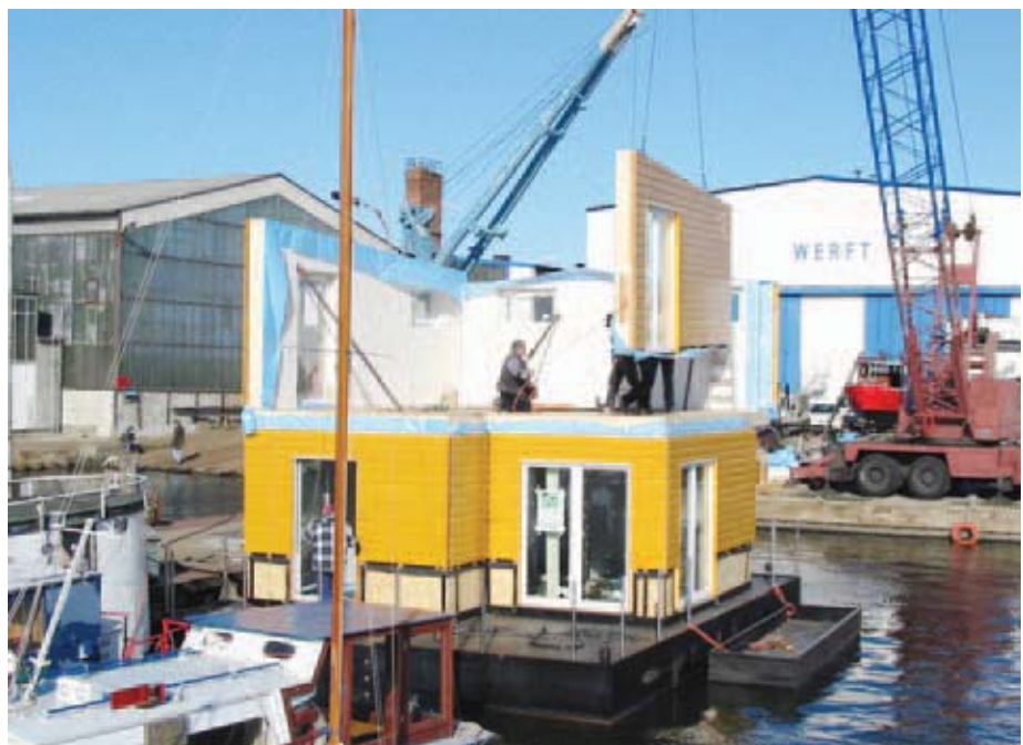
Bild 7 Holzhausmontage in der Werft von Berlin-Köpenik. Die Wände wurden komplett mit Außenschalung vorgefertigt. Im Sockelbereich wird die Schalung erst nach dem Verkleben einer Schürze angebracht.
