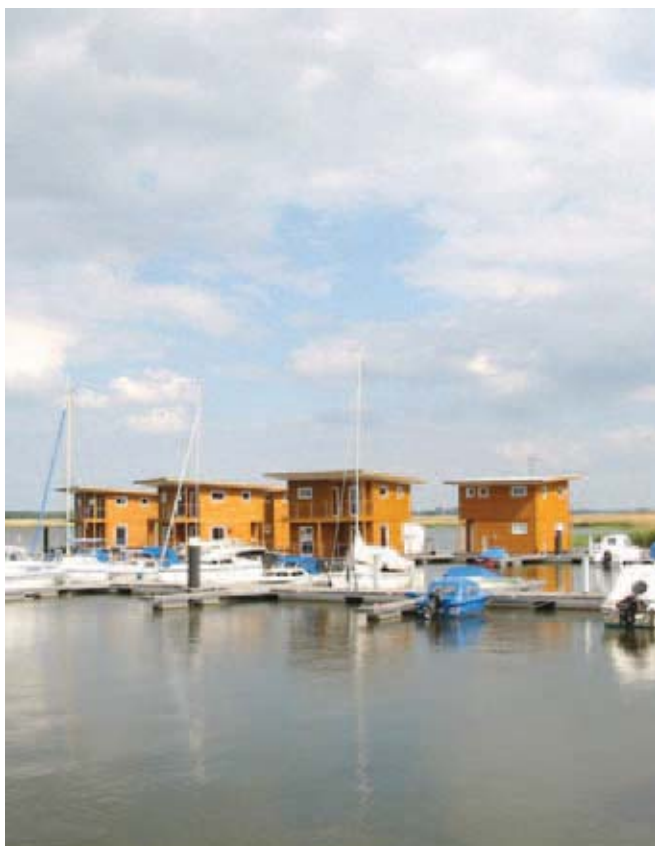
Bild 8 Schon gut ausgelastet sind die Schwimmenden Ferienhäuser.
