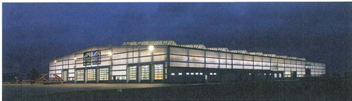
◀ Die neue Fabrikhalle in Neuruppin bei Nacht
