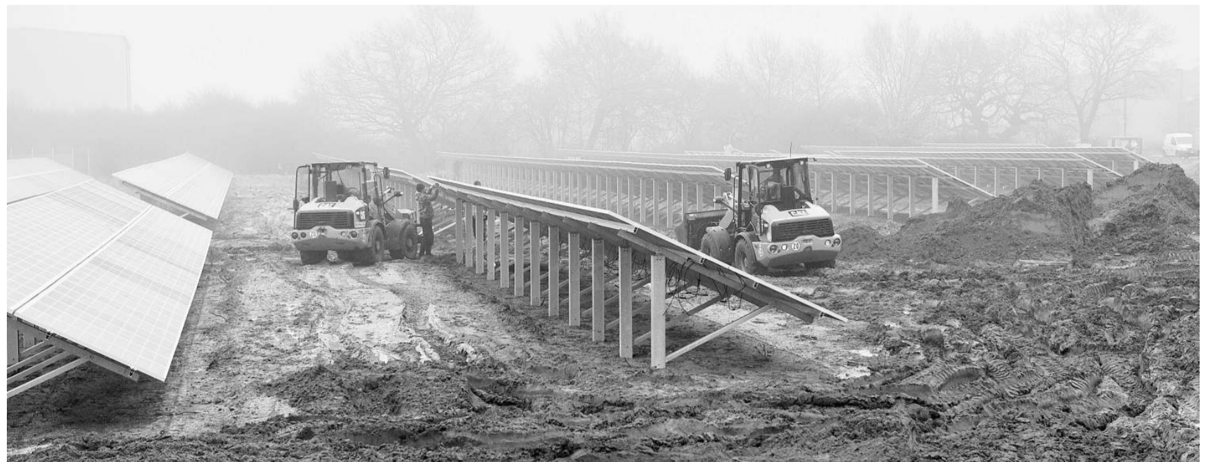
Letzte Aufbauarbeiten auf dem Solarfeld von Opitz. Manche Arbeiter mussten die Nacht durcharbeiten, damit die Photovoltaik heute ans Netz gehen kann. FOTOS (2): PETER GEISLER
