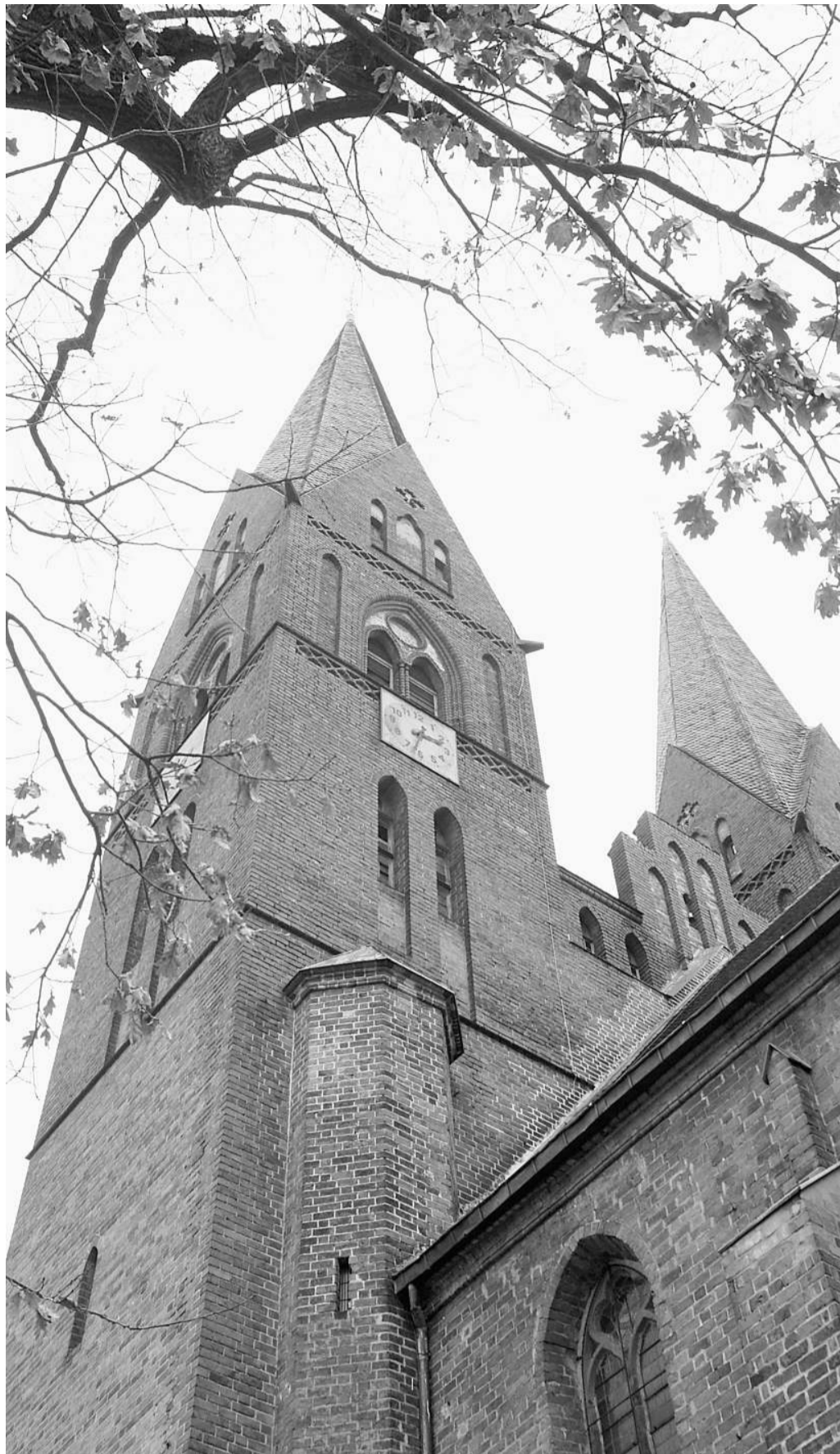
Ein riesiges Gerüst mit Treppentürmen und Fahrstühlen wird um die Kirchtürme gebaut. FOTOS (2): GRUNOW
