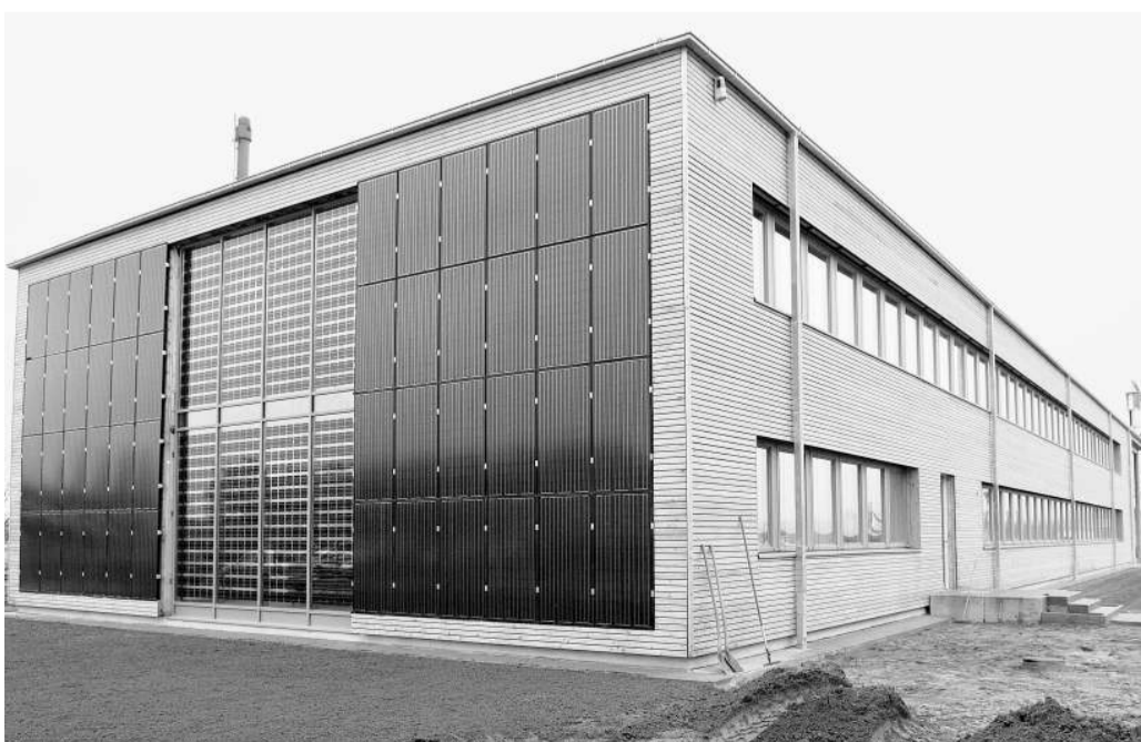
Unter anderem diese Fotovoltaikfassade trägt zur Energiegewinnung bei.
