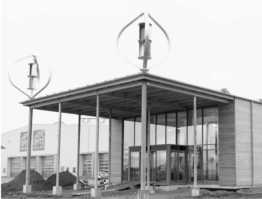
Der Eingangsbereich des neuen Verwaltungsgebäudes der Firma Opitz in Treskow. FOTOS (4): PETER GEISLER
